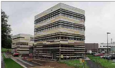
Im Außenbereich bleiben nur noch kleinere Arbeiten zu erledigen. Im Vordergrund erkennt man das Verwaltungsgebäude des Siden.
